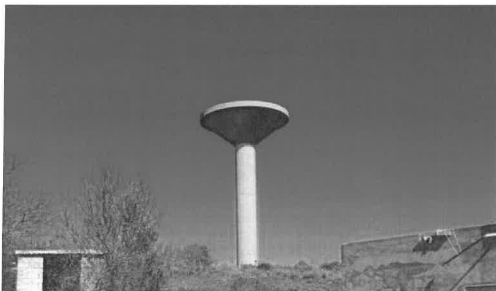
Figure 2 : Château d'eau non-connecté de 250m 3 en cours de réhabilitation en aval d'Aamaret el Bikat
