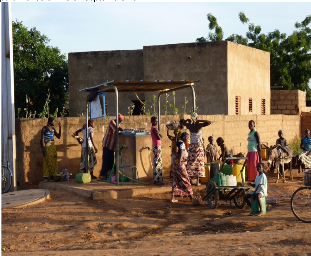
Borne fontaine à Kaya. En milieu urbain, le gestionnaire des ouvrages est l'Office national de l'eau et de l'assainissement (ONEA). En milieu rural, des associations d'usagers de l'eau (A.U.E) sont gestionnaires des forages. Le maître d'ouvrage est la commune qui perçoit une part de la redevance.
